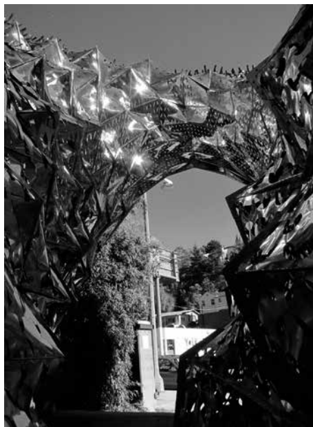
> BLOOM亭子顶上的金属板由于受到阳光照射已经张开，在下部阴影中的金属板则仍处于闭合状态。
